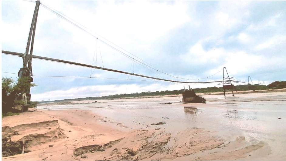
Levantamiento planialtimétrico con estación total calibrada de: Torre #4, muerto #2 y torre #5,
